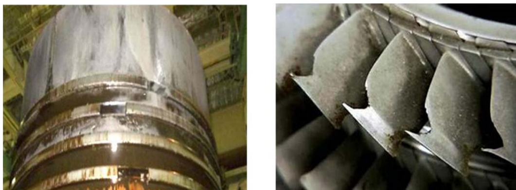
图 1 船机部件的腐蚀
